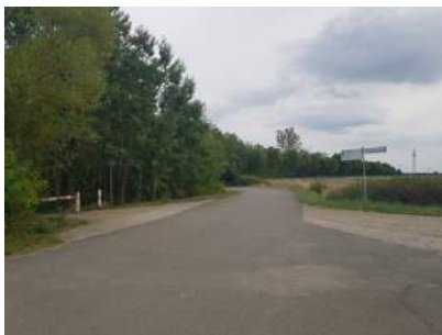
02 Straße Asphalt, Betonbereiche
