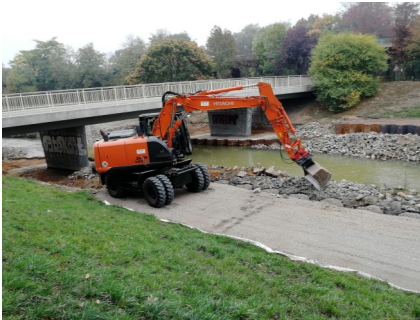
An der Agra-Brücke werden derzeit Spundwände in die Pleiße eingebracht. Foto: KFSL
